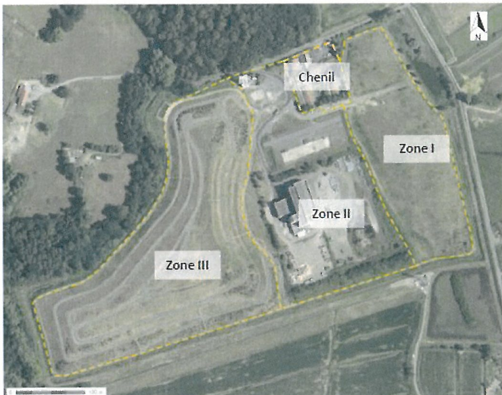
Figure 2 : Vue du site et de ses installations
